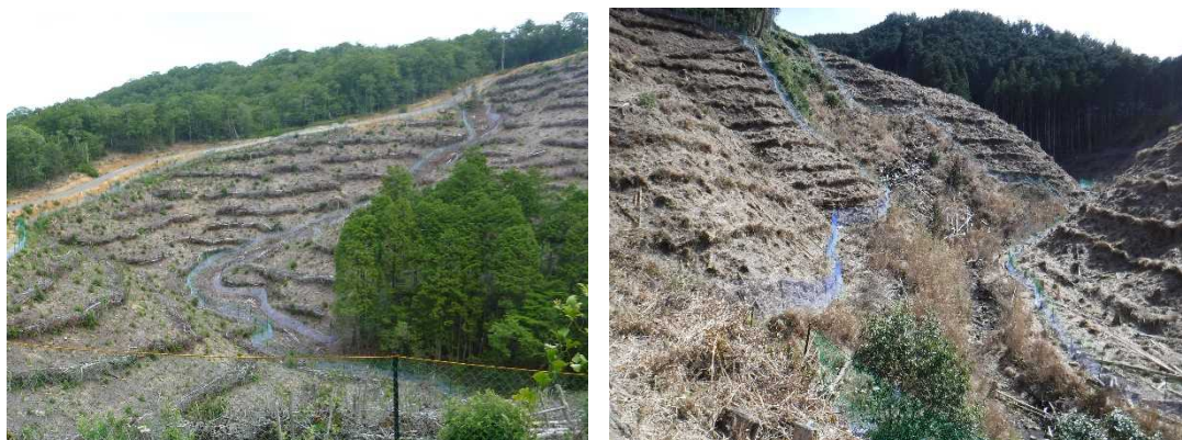
【沢を横断せずに防護柵を設置している事例（沢に沿って防護柵を設置している）】
