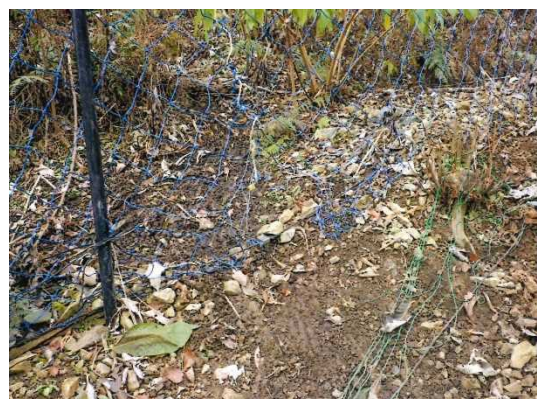
防護ネットの破れ
