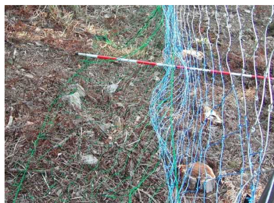
既存の防護ネットにスカートネット（緑色）を設置
