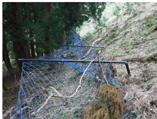
【雪による防護柵の倒壊】
