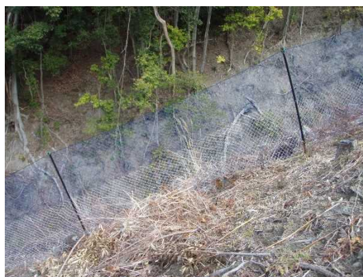
【斜面に対し垂直に設置】
