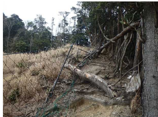
風倒木による防護ネットの破損
