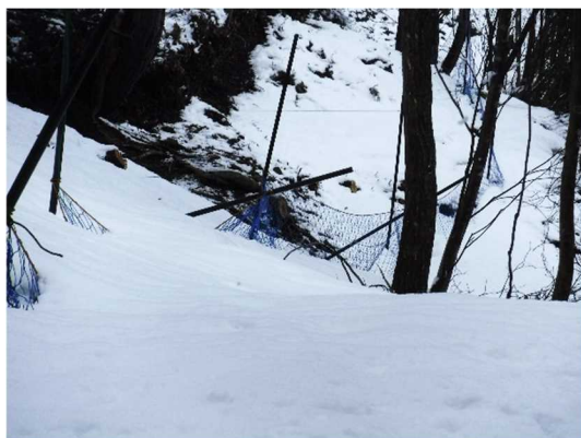
【雪による防護柵の倒壊】
