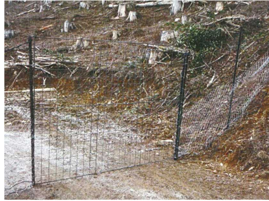
【作業道を横断する場合の扉】
