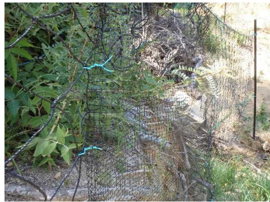
上部からの崩土等に備え防護ネットを補強
