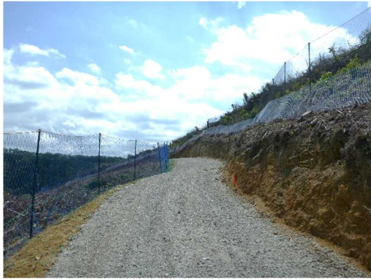
【作業道を除いて防護柵を設置】
