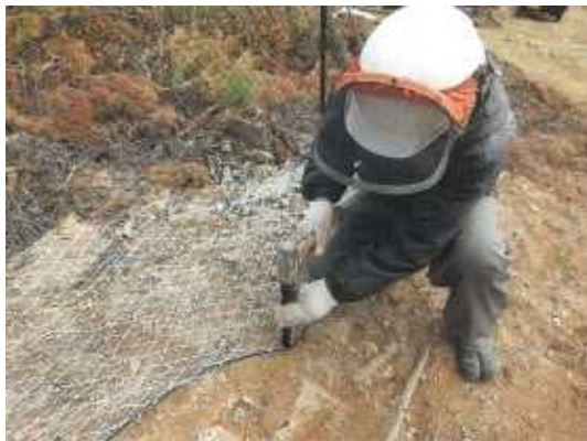
【アンカー杭で固定】
