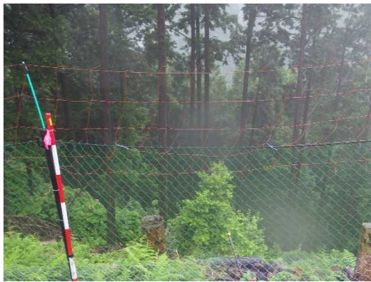
跳び越えを防ぐため防護ネットの上部にネットを追加
