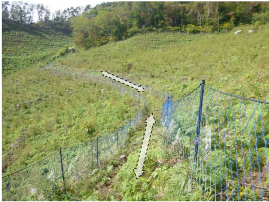
【獣が通るための道（矢印部分）を残置して防護柵を設置】
