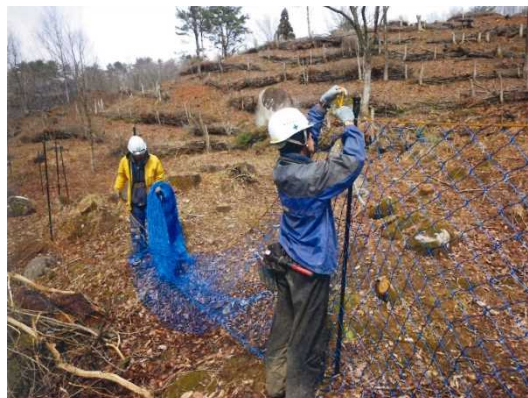
【張りロープ固定、防護ネット展開】
