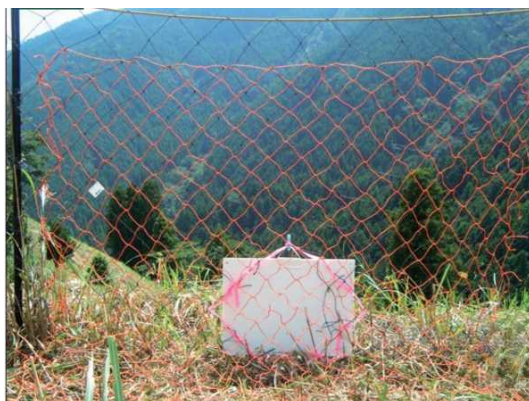
防護ネットの破れた箇所を補修用の防護ネットで接ぎ当て（修理箇所の視認性を高めるため色の違う防護ネットを使用）
