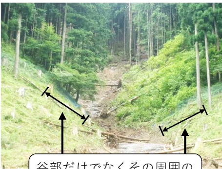
谷部だけでなくその周囲の防護ネットも破損した様子
