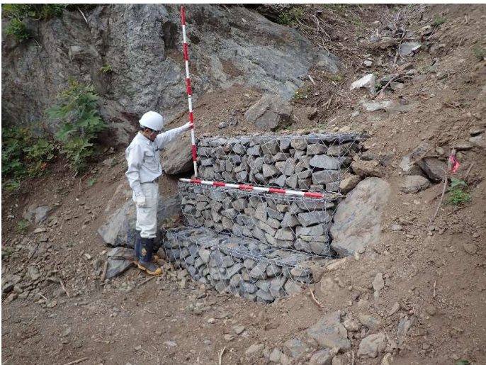
写真10 土留工の実施状況
