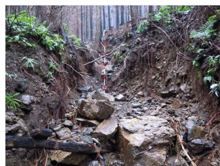
写真4 洗堀被害の状況
