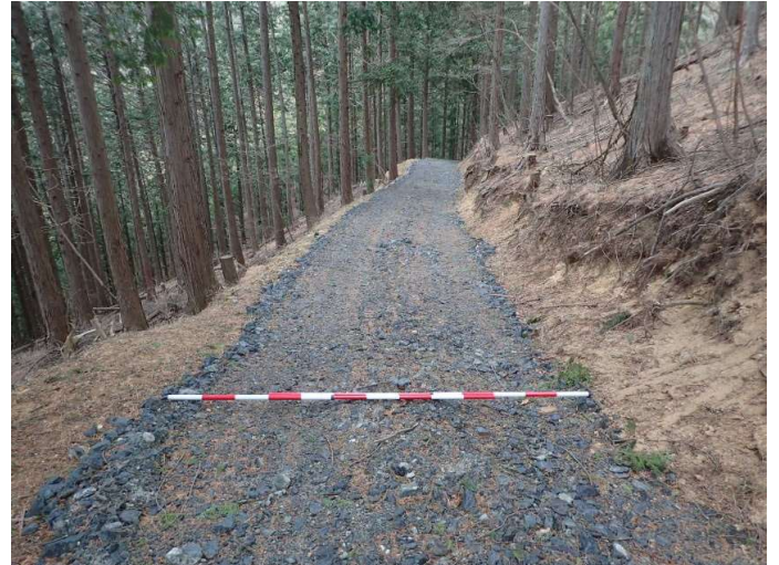
写真9 路面補強工の実施状況
