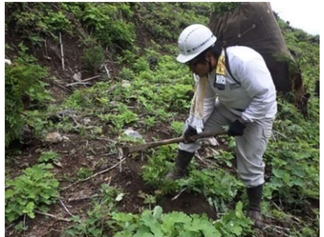
写真7 苗木の植栽作業
