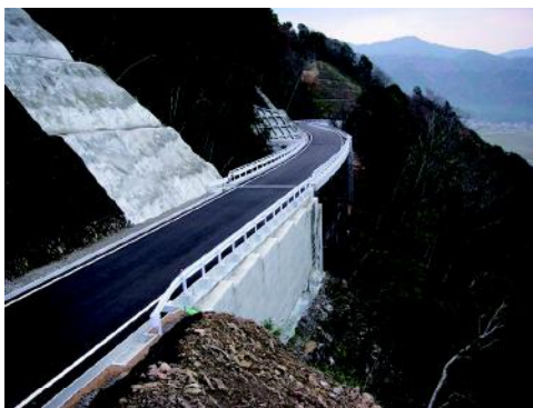
法面の性状により使い分けた工法 (邑智西部区域)
