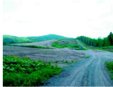
傾斜改良（施工前）
