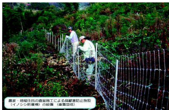
農家らの直営施工による鳥獣害防止施設の設置
