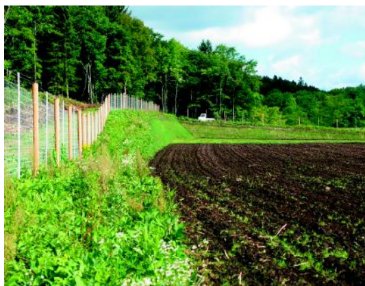
整備された鳥獣害防止柵 (南富良野区域)
