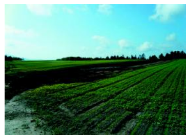
排根線除去（施工後）
