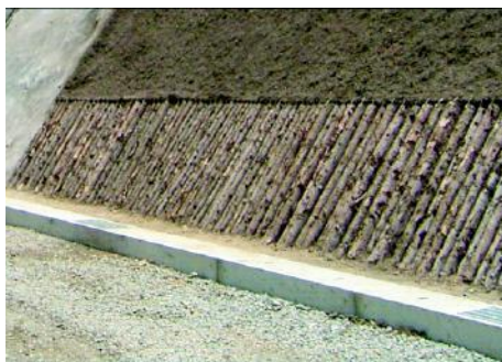
法面の防草処理に丸太を利用 (阿蘇小国郷区域)
