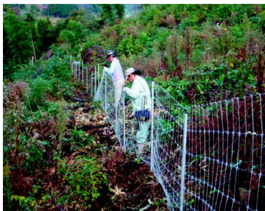
直営施工による鳥獣害防止柵の設置 (邑智西部区域)
