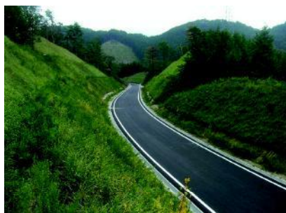
植生工法面 (邑智西部区域)
