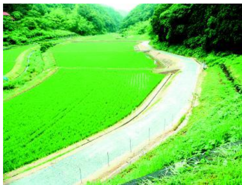
中大型機械作業が可能になったほ場
