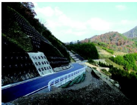
地山補強土工 (邑智西部区域)
