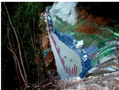
軽量盛土の構築（FCB工法の状況） （邑智西部区域）
