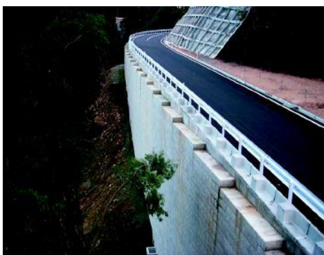
軽量盛土（FCB工法の完成） （邑智西部区域）
