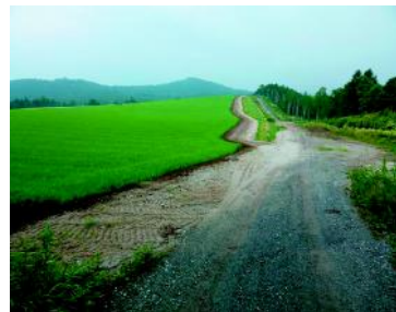
傾斜改良（施工後）
