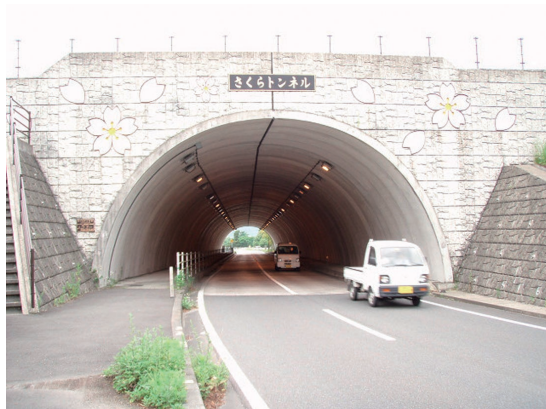
景観に配慮した「さくらトンネル」
