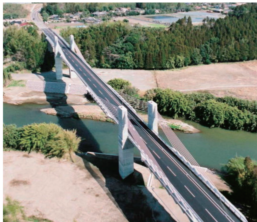
野井倉大橋（大隅中央区域）
