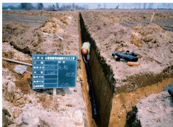
暗渠排水管の布設作業状況
