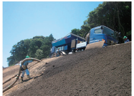
根株チップを吹き付けた法面
