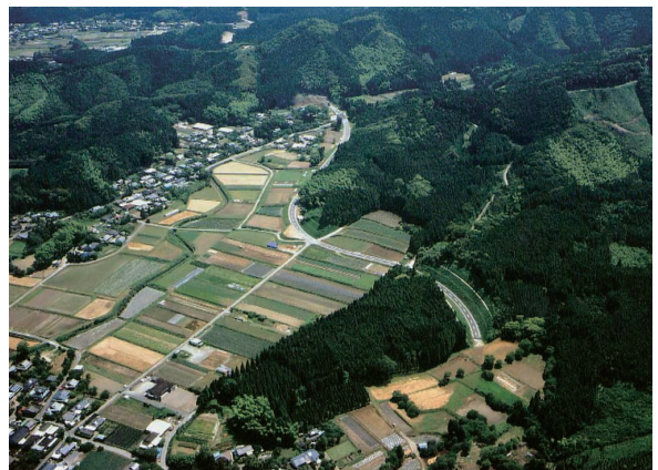
都城盆地内の営農団地を貫通する農業用道路
