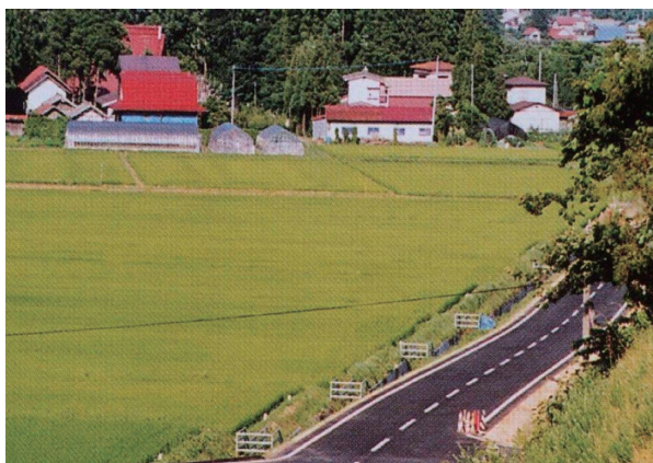
農業用道路とほ場整備の一体的整備
