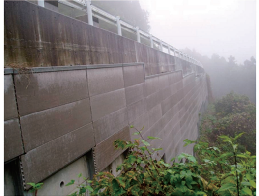
EPS工法で施工した補強土壁工
