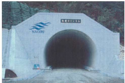
永慶寺トンネル(直入庄内区域)
