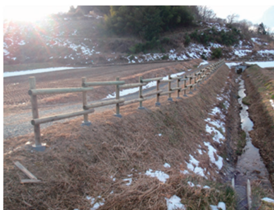
木製転落防止柵
