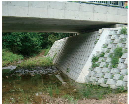
ホタルの生息環境に配慮した環境ブロック
