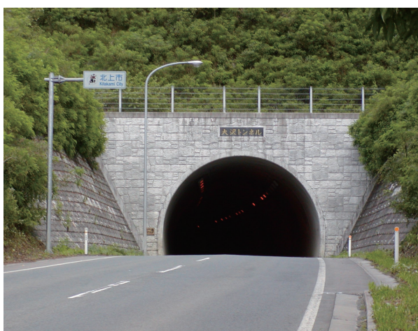
新幹線花巻トンネル上を交差する大沢トンネル(花巻工区)
