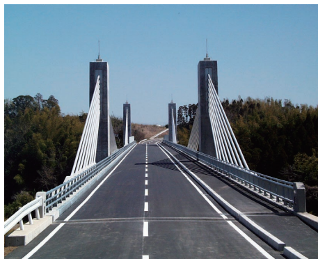
3径間連続PCエクストラドーズド橋 (野井倉大橋)
