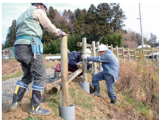
直営施工の実施状況
