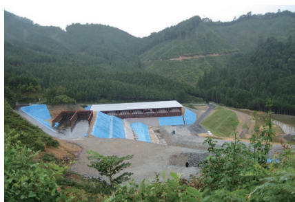
トンネル土捨場の環境整備状況
