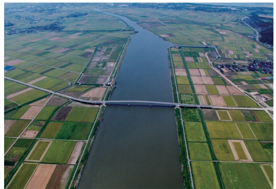
邑知潟面整備と邑知潟大橋
