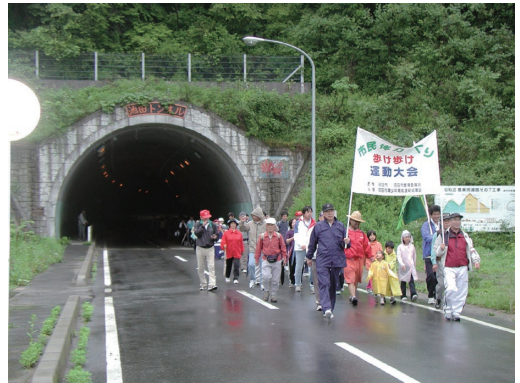
歩け歩け大会（池田トンネル）
