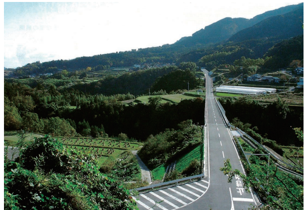
受益地を貫通する農業用道路
