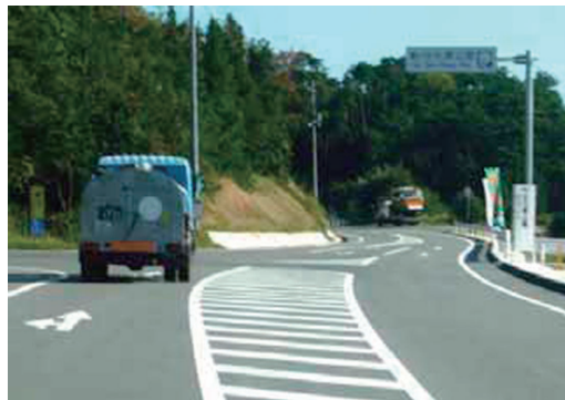
農業用道路の利用状況
