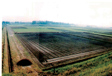
区画整理 (施工後)
