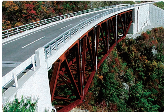
耐候性鋼材を桁に使用した大竹橋
