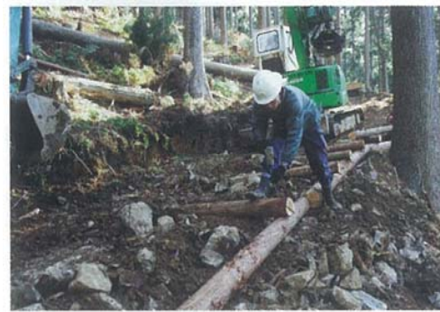
丸太組工法の流れ
