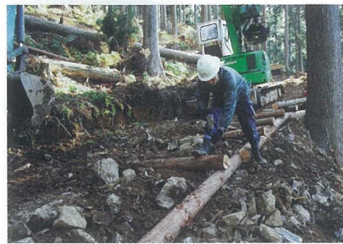
丸太組工法の流れ
