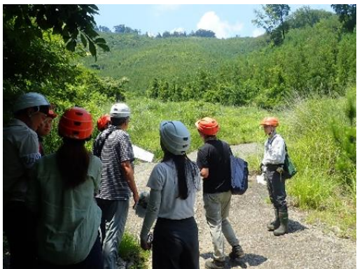
●センターによる復旧後の状況説明
