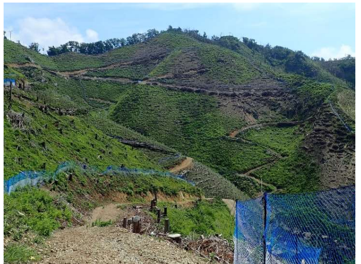
写真11 作業道の整備後
