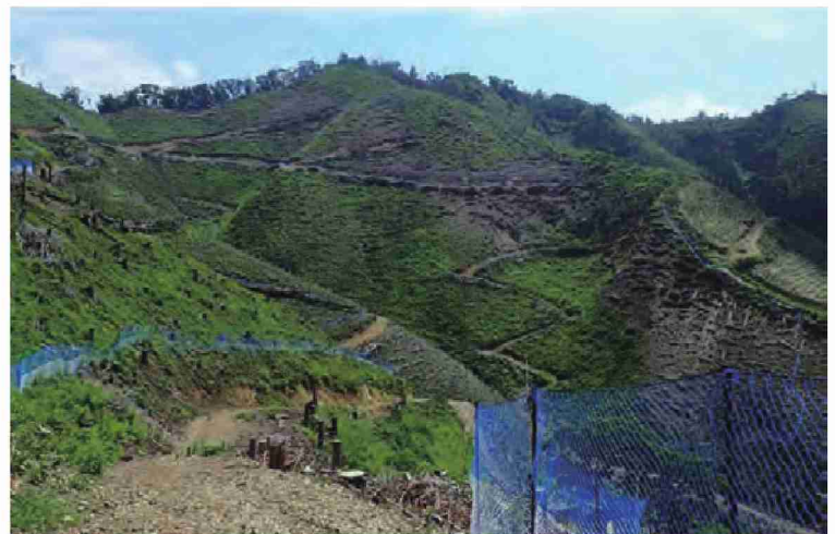
写真9 作業道の整備状況
