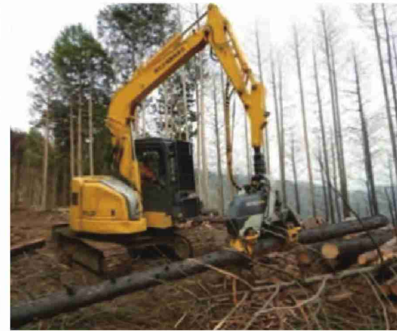
写真5 桐生市による被害木整理の状況
