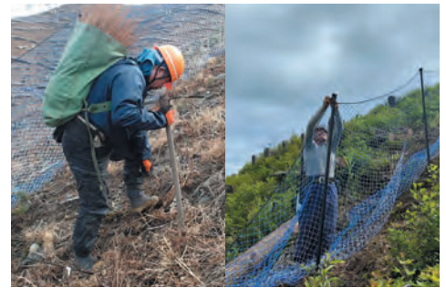
植栽及びシカ害防護柵の設置作業
