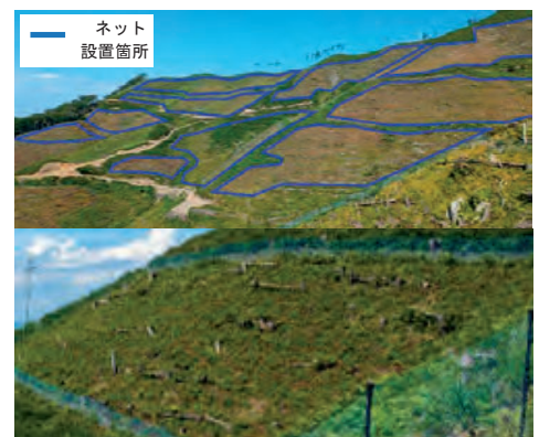
契約地内のシカ害防護柵の配置状況
