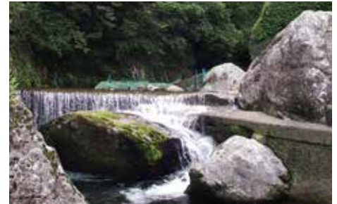
一之瀬地区の簡易水道施設
