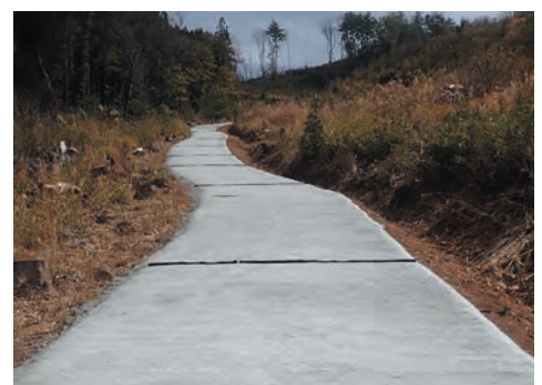
コンクリート舗装による作業道の補修
