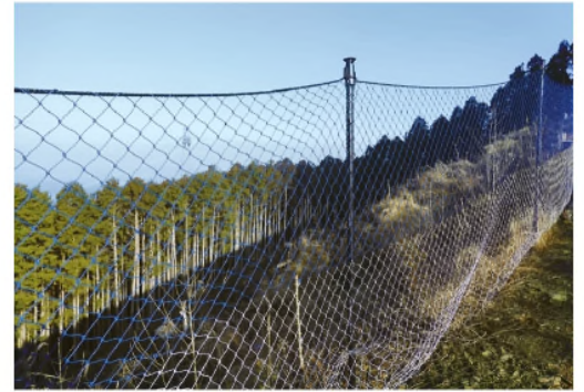
シカ害防護ネットの設置状況
