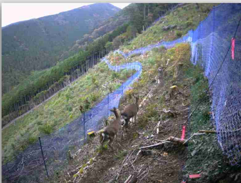
ブロックディフェンスによる シカ防護柵の設置
